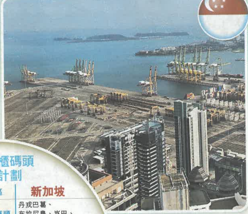
新加坡丹戎巴葛貨櫃碼頭，已於2017年初停用，即發展藍圖公布後第4年。現場所見，碼頭貨櫃以及吊貨設施已經全面搬走。 (文倩婷攝)
